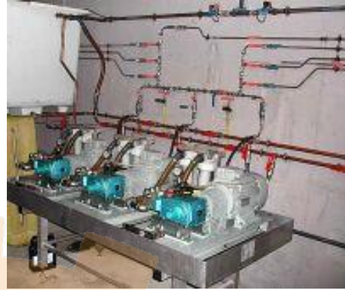
استقرار پمپ سه تایی نوع 1050 . 31 تا 63 لیتر بر دقیقه
