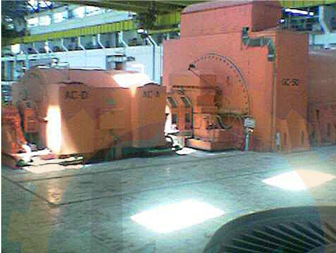
شکل 12-4 : نمایی از ژنراتور و اکسایتر واحد 5 و 6 نیروگاه رامین را نشان می دهد.
